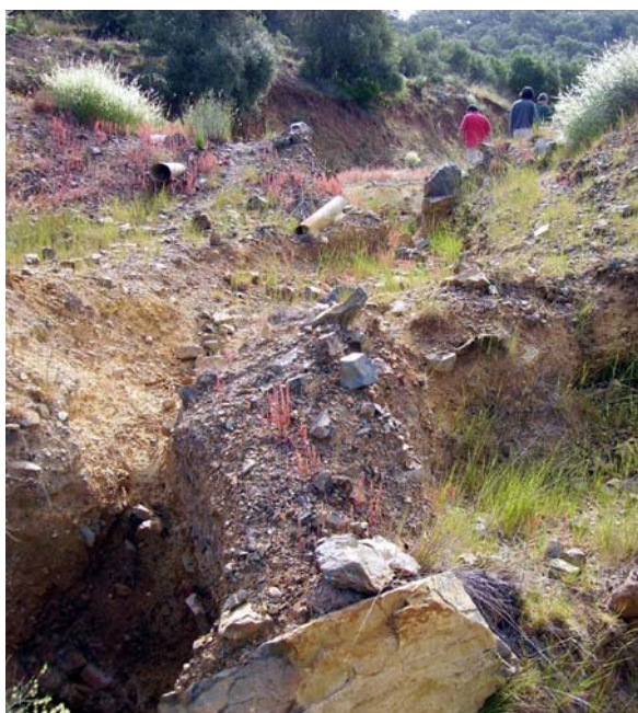
Fotografías 2 y 3. Vistas de la zona de rotura del dique del depósito desde abajo (izquierda) y desde arriba (derecha). Se observa cómo se ha formado un reguero que remonta desde los materiales terrosos y pedregosos del dique (fotografía izquierda) hacia la masa de lodo almacenado (fotografía derecha).
